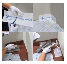
spatola liscia per una larghezza di circa 10 cm avendo cura di riempire le cavità e di lasciare un sottile strato di adesivo al di sopra dei rilievi. Applicare lo stesso adesivo a parete con una spatola dentata 3 x 3 mm per una altezza di circa 10 cm.
