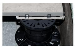
DISTANZIATORE PERIMETRALE PROSUPPORT TUBE SYSTEM Acciaio inox AISI 316L / 1.4404 - V4A - conf. 40 Pz
